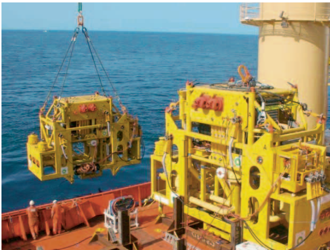
Abb. 2: Installation von zwei Bornemann Subsea Pumpen
